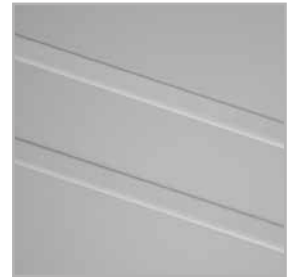
frezowanie na powierzchni skrzydła szerokość 15 mm we wzorach B10-B12
